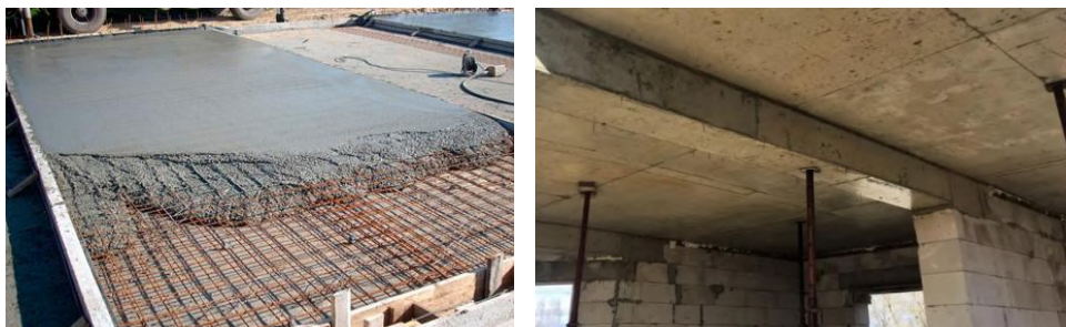
Сурет 3. Монолитті бетон қосылған құрама бетон төбесі
