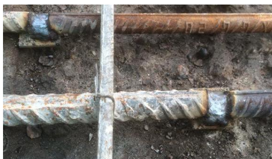
Сурет 4. Арматураны түйістіріп дәнекерлеу
