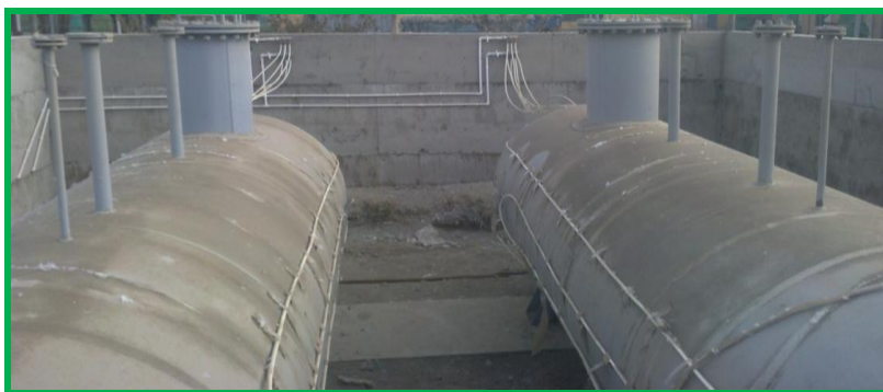
Рис. 6. Общий вид резервуаров для хранения сжиженного пропана, установленных на хлопкозаводе
