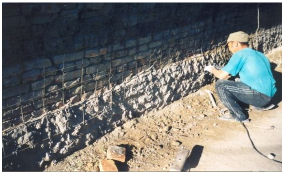
Рис. 3. Усиление стены и фундамента жилого дома в ауле Кызылшаруа
