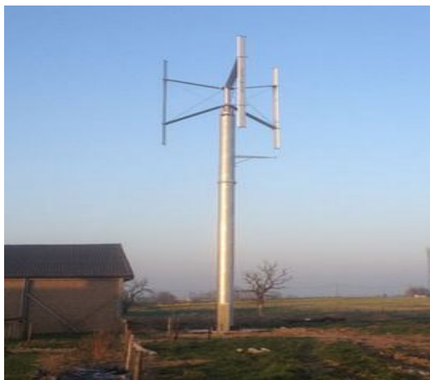
Рис. 6. Вертикально-осевой ветрогенератор F16-05
