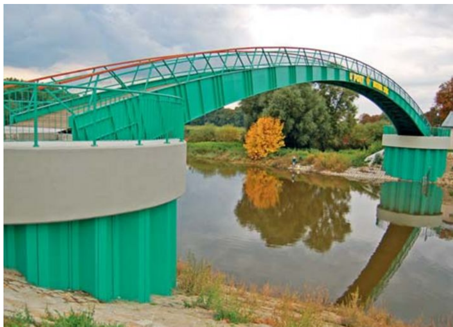
Рис. 6. Причалы пешеходного моста, г. Нова Суль
