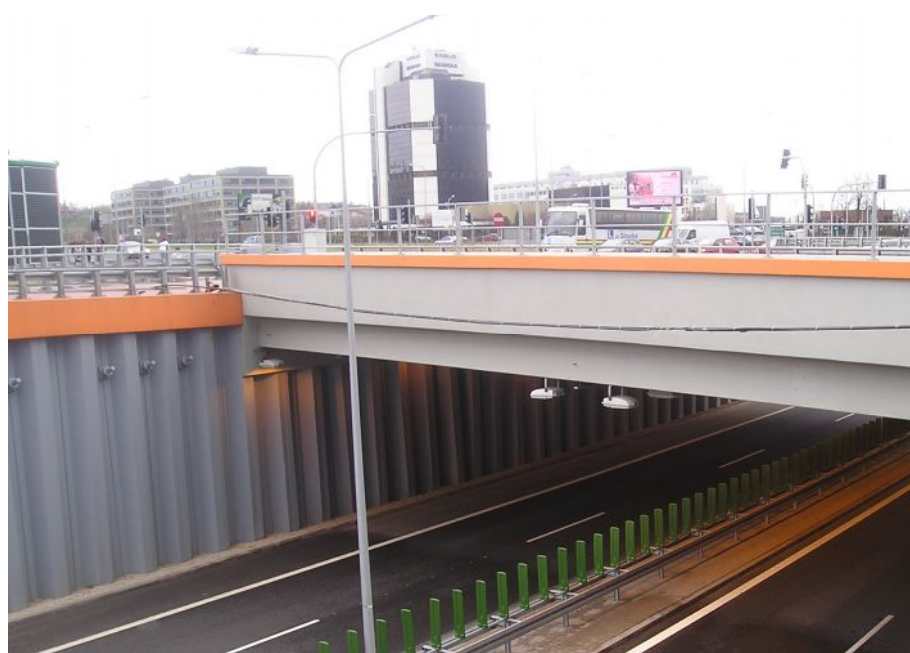
Рис. 5. Автодорожный виадук, г. Келце
